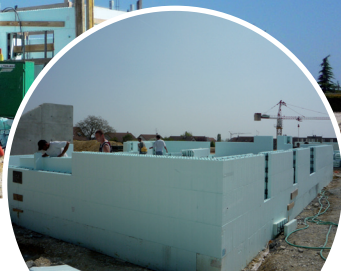
État du chantier après 2 heures de montage
